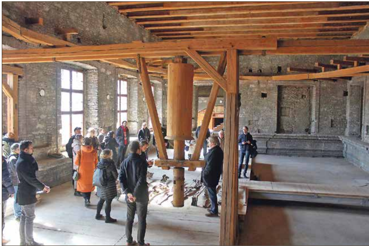
Interiéry Clam-Gallasova paláce prošly rukama řemeslníků a restaurátorů. Na snímku je podkroví s dřevěným jeřábem.
